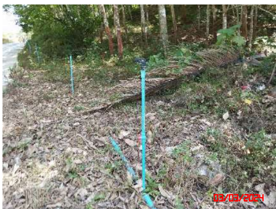
ระบบสปริงน้ำริมเส้นทางขนส่งแร่
